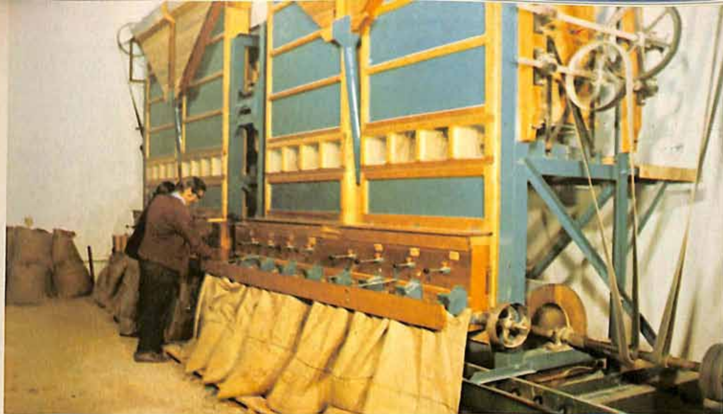
EQUIPAMENTO DA UNIDADE DE BENEFICIAMENTO DE SEMENTES, EM CIANORTE
