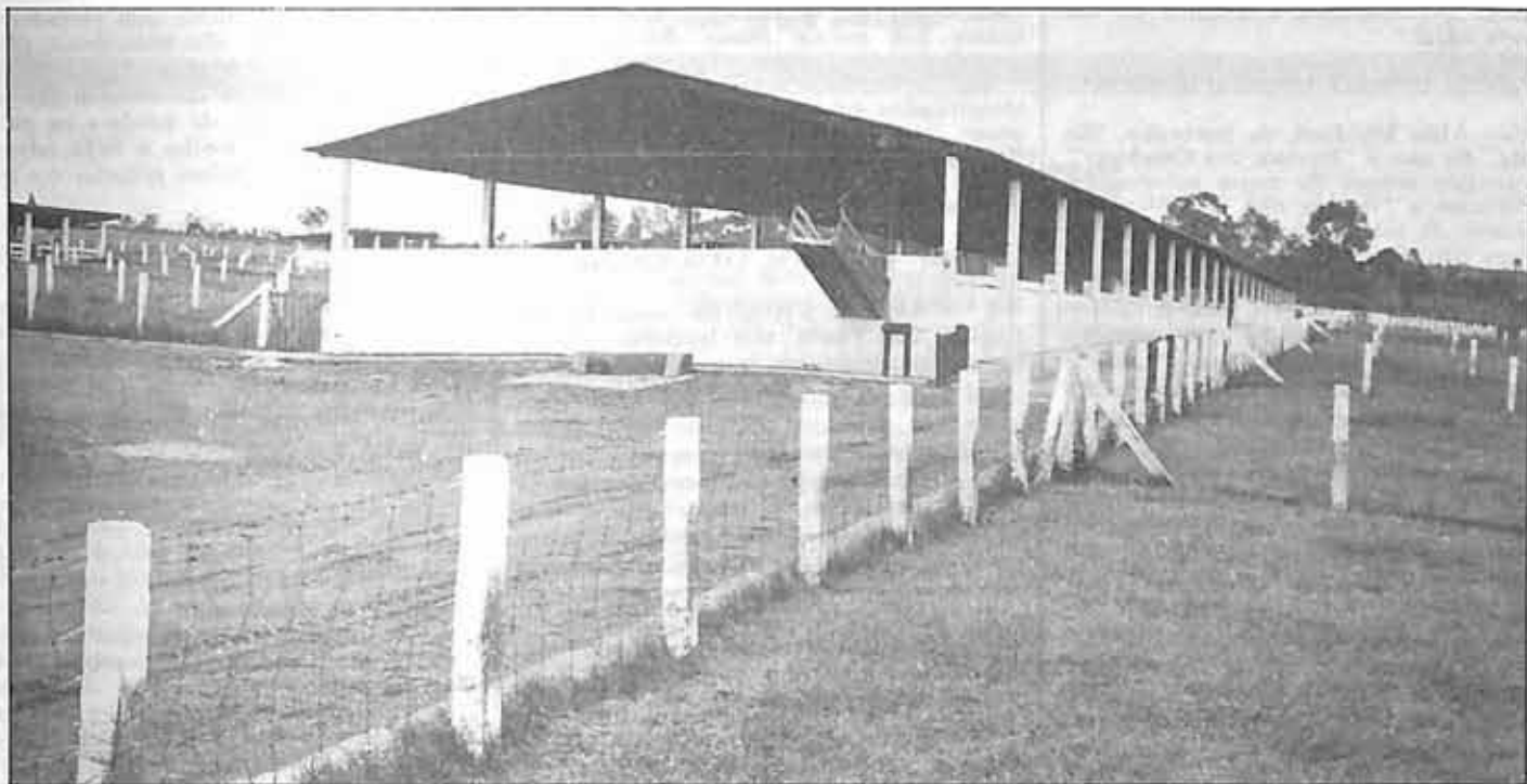
Galpão de terminação, com ponte elevadiça para cruzamento de animais.
