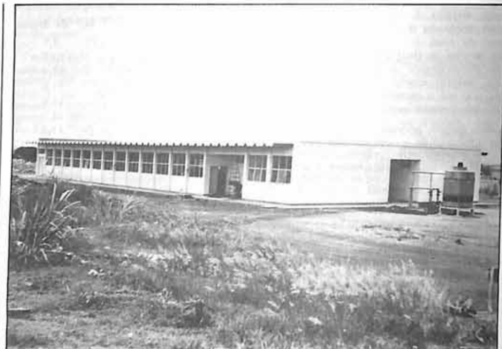
Aspecto do galpão. 80 baias climatizadas.
