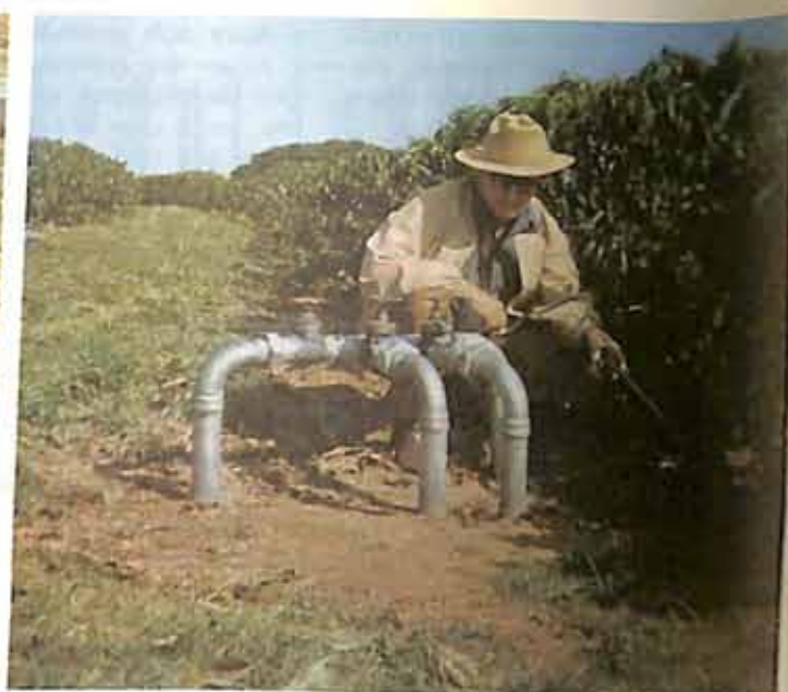
Registros que comandam o fornecimento de água.
