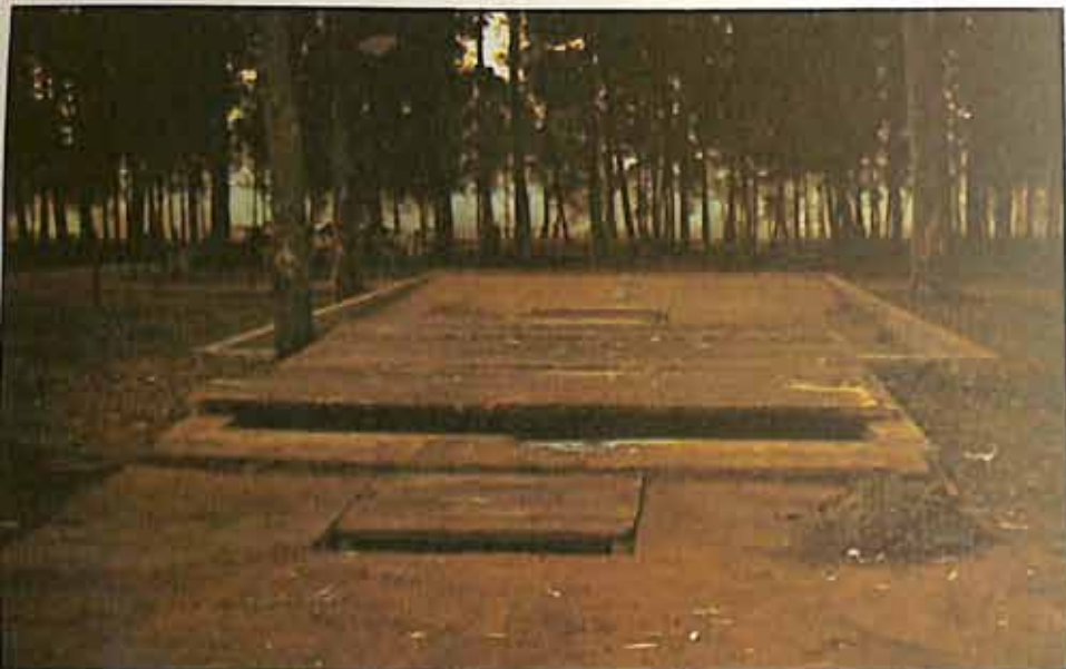
Captado subterraneamente o esterco é depositado neste tanque de chorume.
