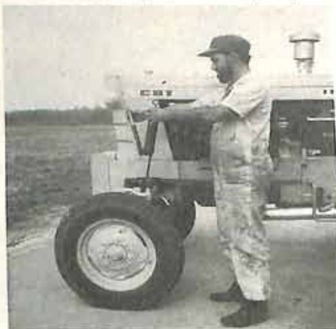
Lubrificação com graxa do mecanismo da direção.
