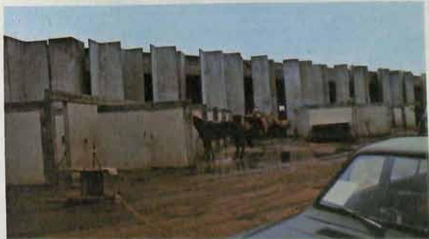
Paredes de concreto dificultam a ventilação dentro do pavilhão.
