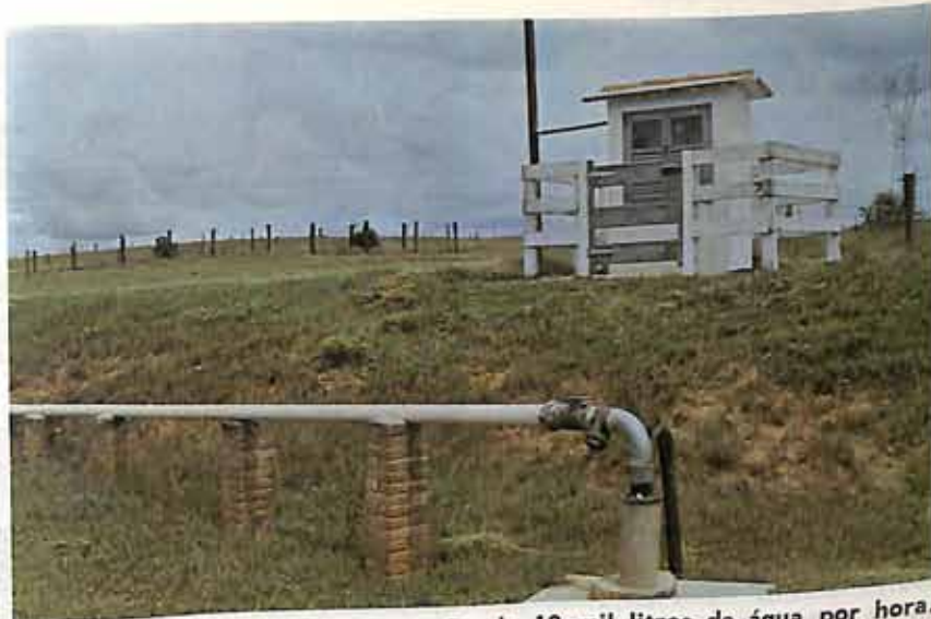
Este poço artesiano tem uma vazão de 18 mil litros de água por hora.
