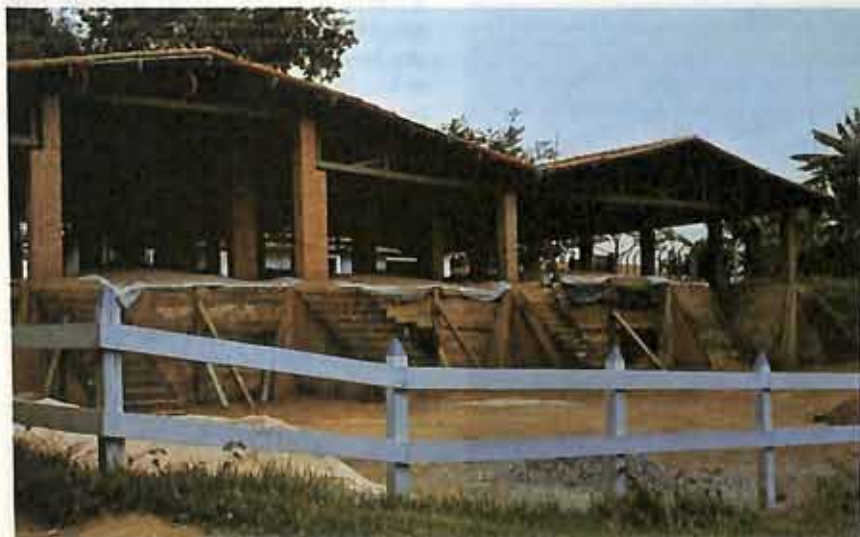
A Rio Verdinho estoca 521 toneladas de silagem em sete silos de encosta.
