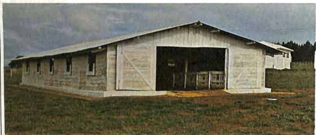
O bezerreiro da Santa Andréa tem solução própria, aproveitando madeira solidamente plantada no terreno
