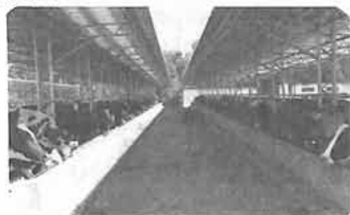
Vista de dois dos oito comedouros existentes na fazenda com capacidade para 384 animais.
