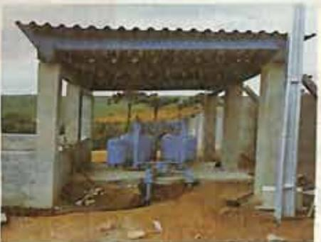
Estação de controle usada em gotejamento, com filtros de tela e areia e misturador de adubo.
