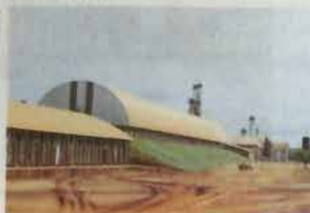
Em armazéns e silos, capacidade para 84 mil toneladas.
