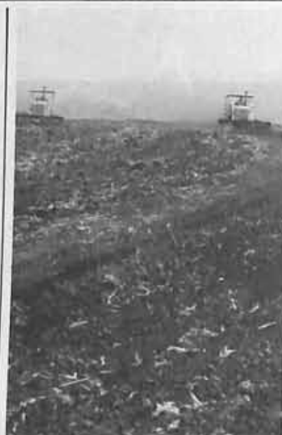
Tratores de esteiras construindo terraços
