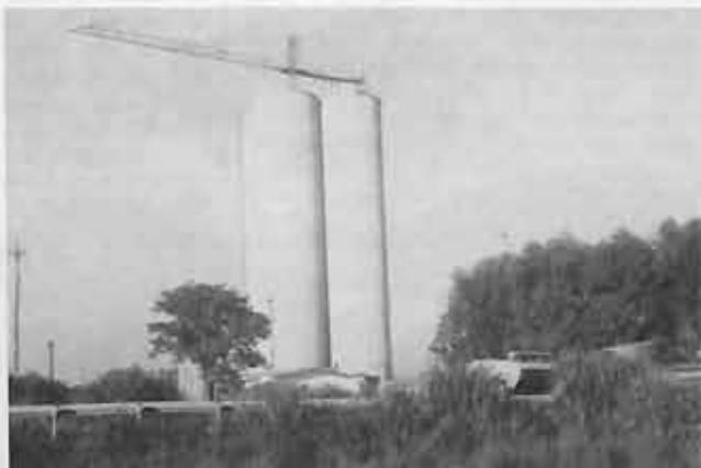
**Silo aéreo de concreto para armazenagem de grãos**
