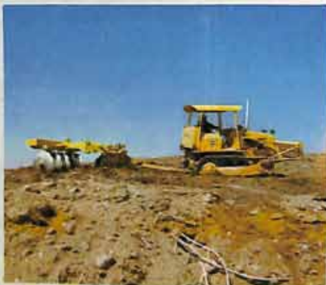
Enleiramento de vegetação executado por um D4E.
