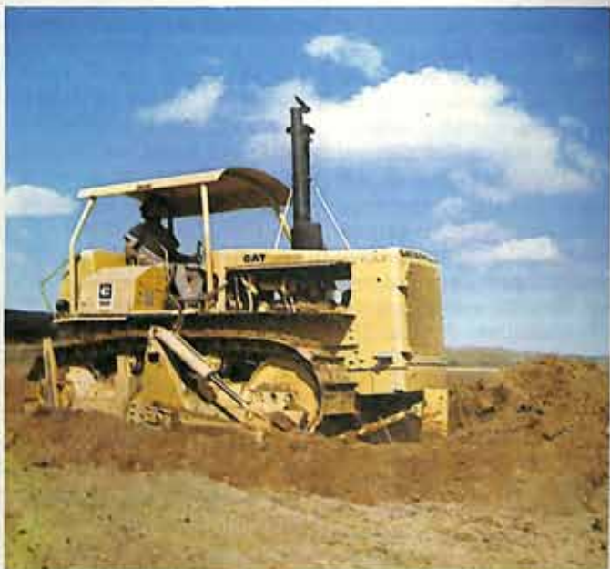
D6D SA com lâmina agrícola realizando serviço de construção de curva de nível.
