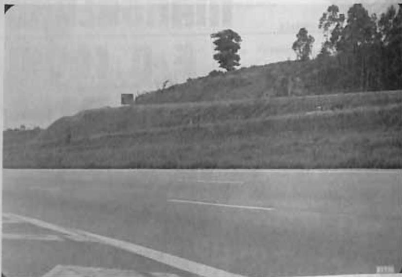
Encosta semeada através da hidrosemeadura.
