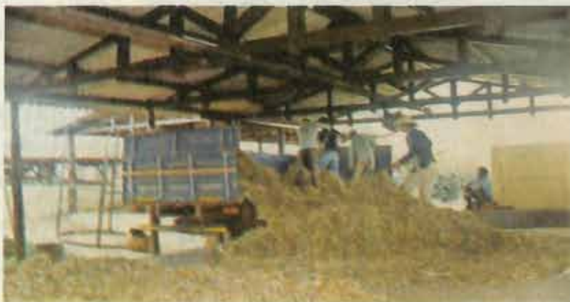
Bateria de silos subterrâneos com capacidade para 460 toneladas.
