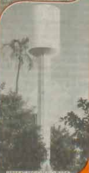
RESERVATÓRIO DE ÁGUA
