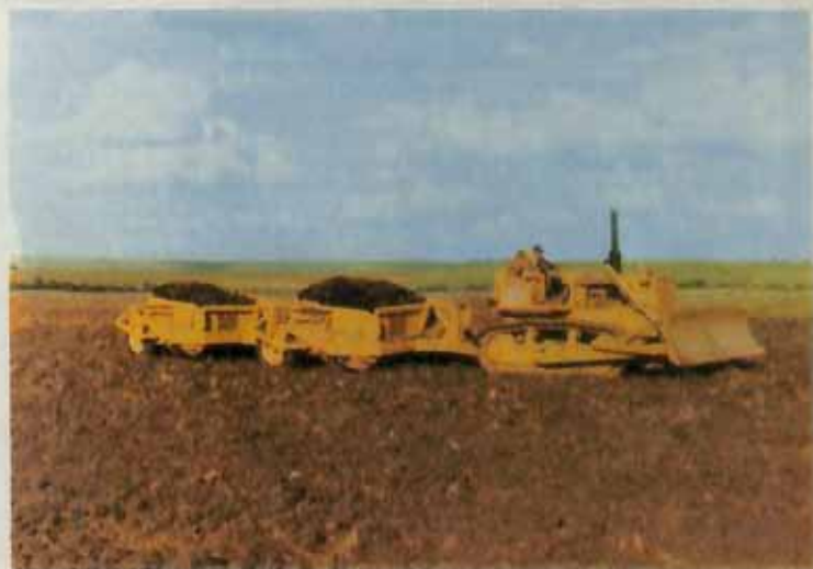
Tracionando conjunto de escrepores (20 m 3 , por viagem)
