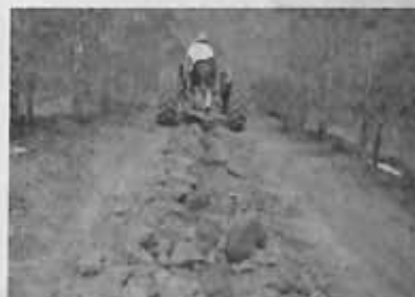
Escarificação no centro da rua em cascalho.
