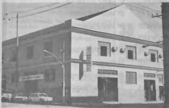
A sub-sede no Rio de Janeiro à rua Monsenhor Manoel Gomes, 3, São Cristóvão.
