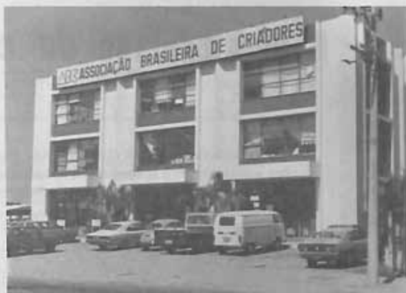
A loja à Av. José Cesar de Oliveira, ao lado da qual, à esquerda, está sendo construído o edifício da nova sede social da ABC.
