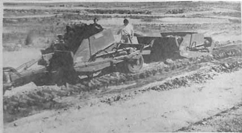
Scraper com duas unidades ou em "tandem"
