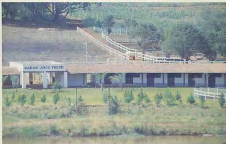
Vista parcial das 36 baias
