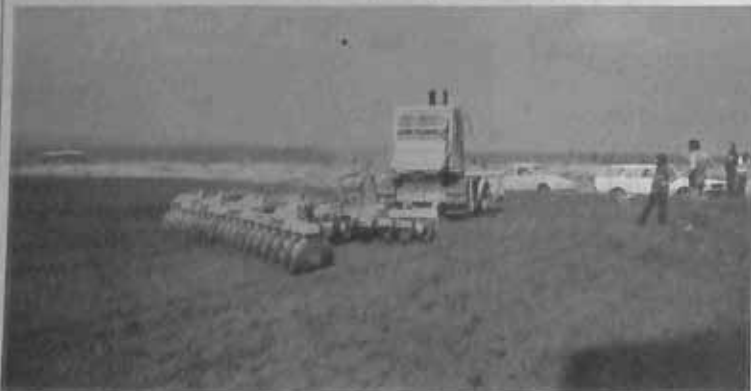
Grade niveladora no preparo final do solo.
