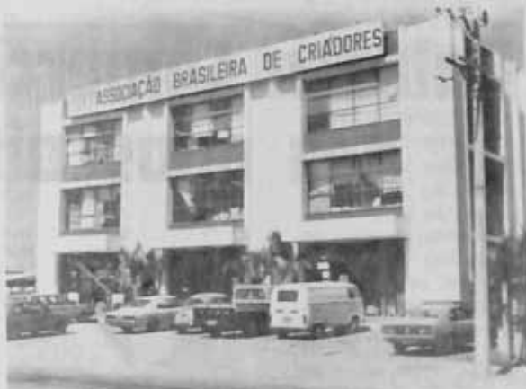
A loja à Av. José César de Oliveira, ao lado da qual, à esquerda, está sendo construído o edifício da nova sede social da ABC.
