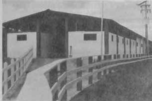
Vista parcial das instalações do Heras 2M.
