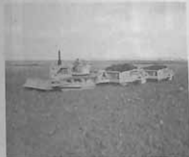
Macronivelamento através de escrepadeiras
