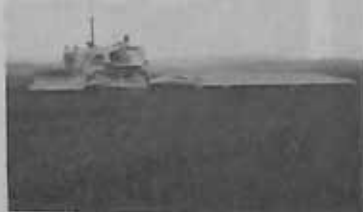
Micronivelamento com plaina niveladora
