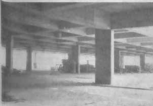
Detalhe do 1º sub-solo da garagem.
