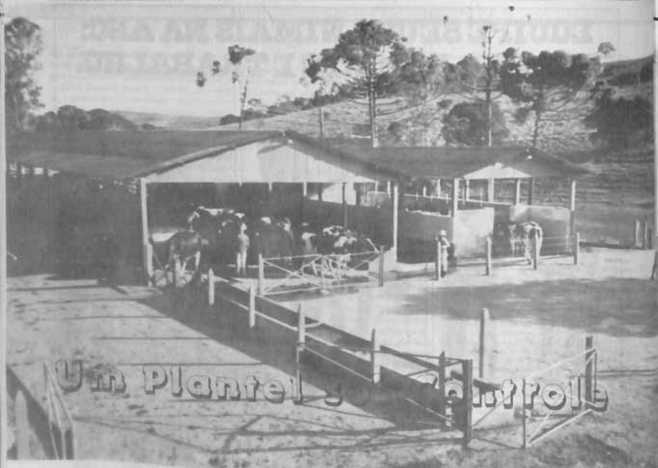
Vista do Estábulo e Sala de Ordenha
