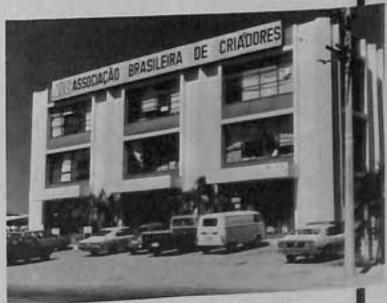
A loja à Av. José Cesar de Oliveira, ao lado da qual, à esquerda, está sendo construído o edifício da nova sede social da ABC.
