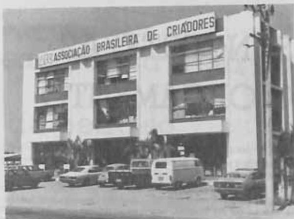
A loja à Av. José Cesar de Oliveira, ao lado da qual, à esquerda, está sendo construído o edifício da nova sede social da ABC
