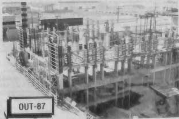
Estruturas das obras. Já estão concretizados o 1º e 2º sub-solos, a laje da loja, do mezanino e do 1º e 2º andares.
