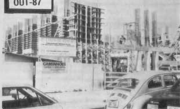
Estruturas das obras. Já estão concretizados o 1º e 2º sub-solos, a laje da loja, do mezanino e do 1º e 2º andares.
