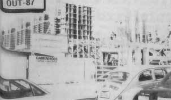
Estruturas das obras. Já estão concretizados o 1º e 2º sub-solos, a laje da loja, do mezanino e do 1º e 2º andares.
