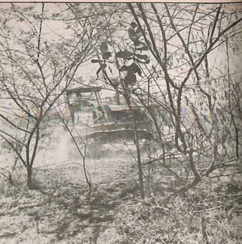
Trator D5DSR de potência variável 140/190 HP, realizando limpeza inicial da área a ser sistematizada.
