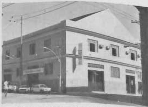
Séde Regional do Rio de Janeiro, à Rua Monsenhor Manoel Gomes, 3 e 3 A, junto a praça da Igrejinha, São Cristóvão, Rio de Janeiro, RJ.
