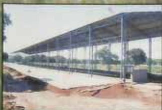
Calção com 240 metros de comprimento.
