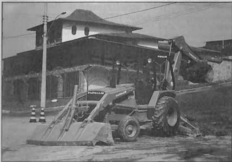
Retro-escavadeira em operação
