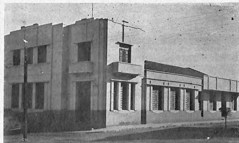
O novo Edifício do Paço Municipal
