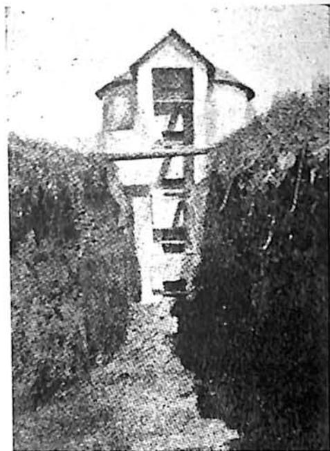
Um silo de encosta — o primeiro que se construiu no Brasil. A carga e a descarga fazem-se por gravidade.
