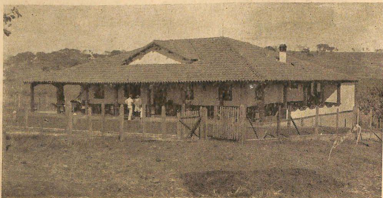
A sede e residência do proprietário da fazenda.
